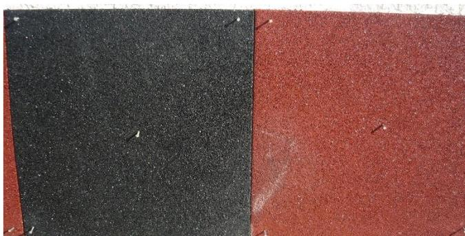
Appliquer la plaque « Protect Mur » contre le mur en appuyant fort et en tapotant avec un maillet caoutchouc.
